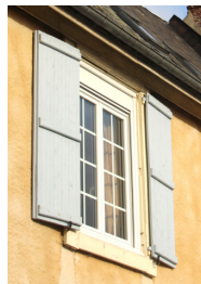
Petits bois intégrés dans le double vitrage.
