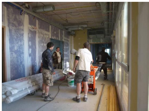
Pôle enfance du Merlerault en construction
