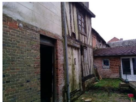
Immeuble à rénover
