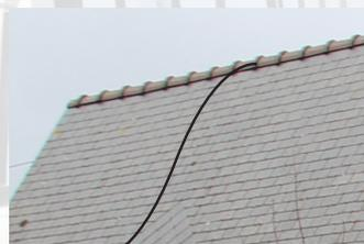
Le **faitage** peut être en terre cuite sur les couvertures en ardoises (photo) ou en tuiles. Le **faitage** peut aussi être en zinc prépatiné sur les toitures en ardoises ou à **lignolet**.
