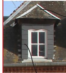
Les arêtiers en zinc sont trop présents sur une si petite surface de couverture. Préférer les arêtiers «fermé» (sans zinc apparent) en ardoise.
