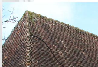
Sur une couverture en tuiles, **Parétier** peut être en mortier ou en tuile.
