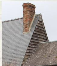
Ce sont de beaux ouvrages qu'il faut maintenir et restaurer. Les joints sont réalisés au mortier de chaux. Le rétrécissement des sorties de conduit de fumée doit être invisible dans la mesure du possible par dissimulation des poteries à l'intérieur de la souche.
