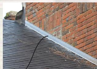
Pour les rives latérales, la protection de la jonction entre la toiture et un mur se fait par les **solins**, réalisés soit en mortier de chaux aérienne (CL ou DL) et/ou de chaux hydraulique naturelle (NHL 2 ou NHL 3,5) (photo de gauche), soit en zinc pré-patiné laissé apparent (photo de droite).
