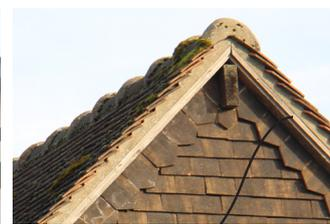
En pignon, le chevron de rive des toitures en ardoises sera laissé apparent ou protégé d'une **bande de rive en zinc** de teinte anthracite. Il peut être protégé par des **ardoises de rives clouées** (pose en bardeli - photo de gauche) dans le cas de pignons exposés aux intempéries. Le chevron de rive des toitures en tuiles plates sera laissé apparent (photo de droite).
