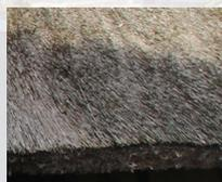
Le chaume, humble et local, faiblement étanche, peut être utilisé dans les cas de toitures à fortes pentes, d'environ 60°, sur le bâti rural.
