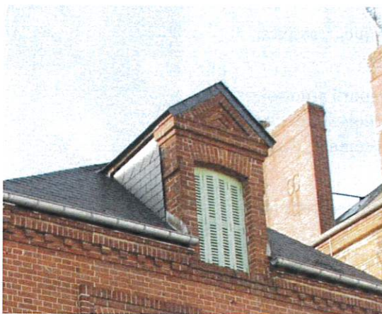
Lucarne à fronton passante, interrompant l'égout du toit.
