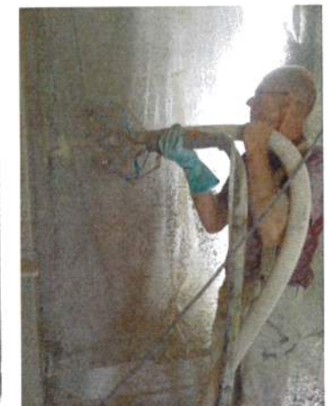
Enduit intérieur réalisé en chaux-chanvre en deux couches : un dégrossi de 6 cm et un enduit de finition de 2 cm (à gauche). Projection du dégrossi à la machine permettant d'avoir des temps de séchage moins longs).
