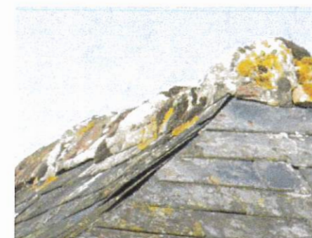
L'étanchéité des arêtières est obtenue par le croisement du chant des ardoises ou par noquet non apparent.
