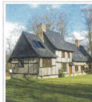
☛ Chauffe-eau solaire individuel, De Bos Hébert
