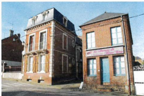
La pierre est utilisée avec parcimonie, ici à gauche encadrements des baies, chaînes d'angle, bandeau, corniche et balcon.
