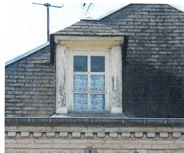
Lucarne à fronton avec menuiserie peinte en trompe-l'oeil
