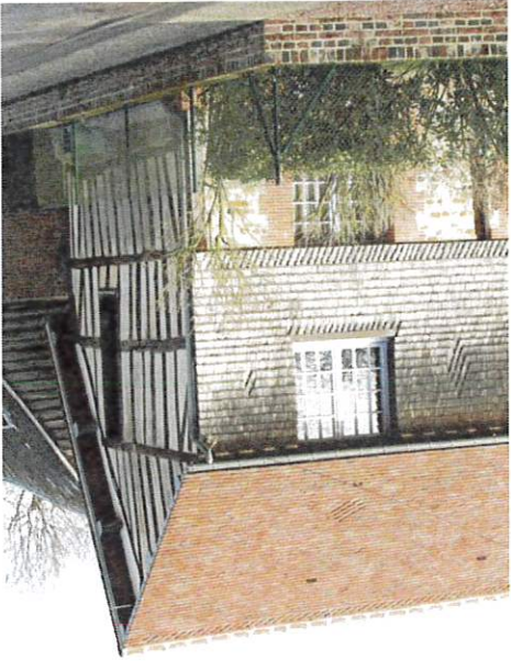
Le torchis fait de terre et de paille est maintenu par un lattis cloué entre les poteaux. Un enduit à la chaux vient le recouvrir à l'extérieur.
