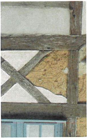
Le torchis fait de terre et de paille est maintenu par un lattis cloué entre les poteaux. Un enduit à la chaux vient le recouvrir à l'extérieur.
