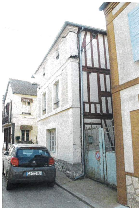
Façade en briques sur rue, façades latérales et arrières en pan de bois, ainsi que les dépendances.
