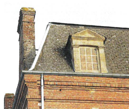
Lucarne à fronton avec menuiserie peinte en trompe-l'oeil
