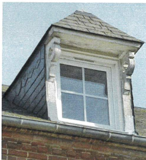
Lucarnes en bois, couverte en pavillon, avec corniche ou jambage sculptée.
