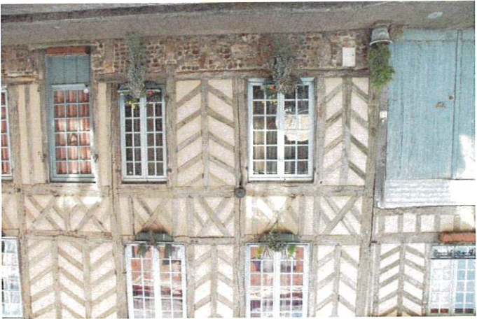
Colombage à profil du pays d'Ouche (à gauche) et profil Augeron (à droite) Le pays d'Ouche est une région de bois alors que le pays d'Ouche est traditionnellement plus boisé. D'où l'emploi de bois plus conséquent dans le profil Augeron. Il n'y a qu'un seul exemple de façade à encorbellement sur la commune.
