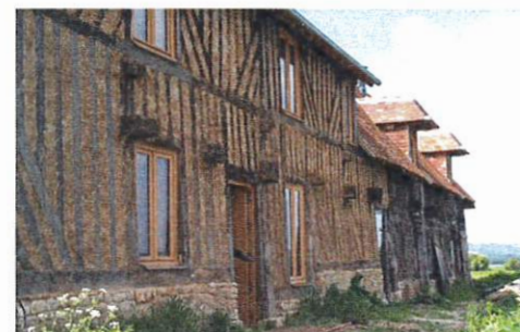
Réfection du remplissage en mélange terre/paille. Un enduit à la chaux hydraulique naturelle permettra de protéger le remplissage côté extérieur.
