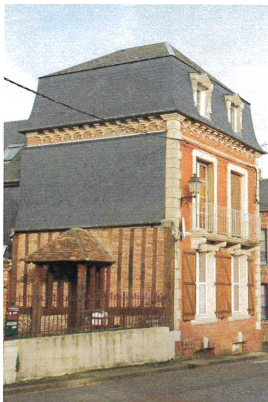
Façade en briques sur rue, façades latérales et arrières en pan de bois, ainsi que les dépendances.
