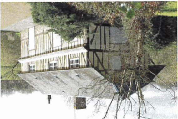
Maison isolée lieu dit « Le Bas de Paperotte ». Maison vraisemblablement surélevée lors du remplacement du chaume par de l'ardoise.
