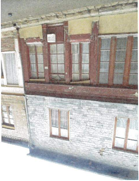
Façades à colombage recouvert d'ardoises.
