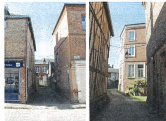
Vue vers cours arrières depuis la place
