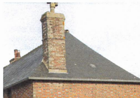
L'étanchéité des arêtières est obtenue par le croisement du chant des ardoises ou par noquet non apparent.
