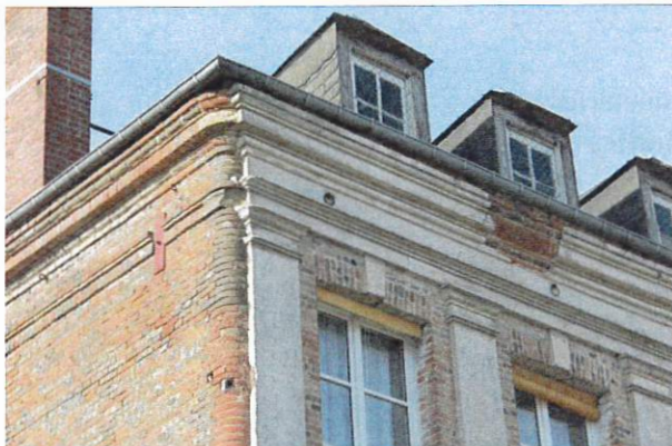
La modénature en brique sous le décor en mortier de la façade principale est visible sur les façades en retour non enduites. Des briques moulées ont été employées pour former les angles arrondis des façades.
