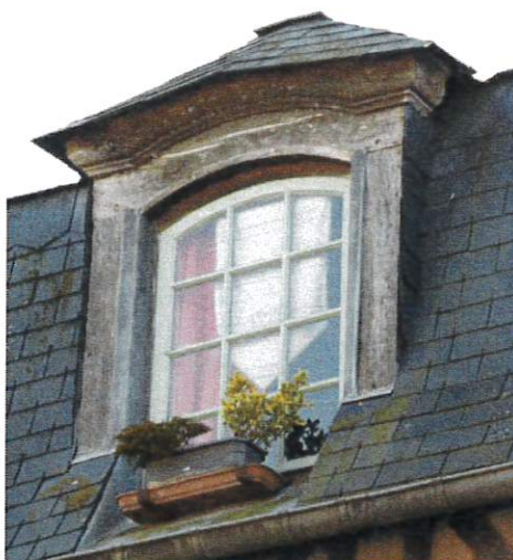
Lucarnes en bois, couverte en pavillon, avec corniche ou jambage sculptée.
