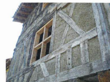
Réfection du remplissage en mélange chaux/chanvre. Un enduit à la chaux hydraulique naturelle viendra protéger le remplissage à l'extérieur
