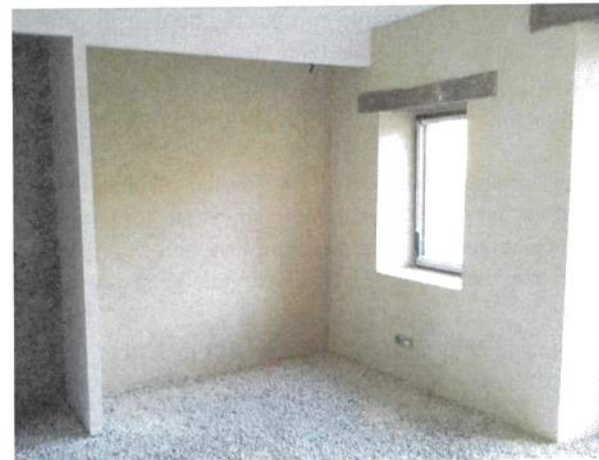
Enduit intérieur réalisé en chaux-chanvre en deux couches : un dégrossi de 6 cm et un enduit de finition de 2 cm (à gauche). Projection du dégrossi à la machine permettant d'avoir des temps de séchage moins longs).
