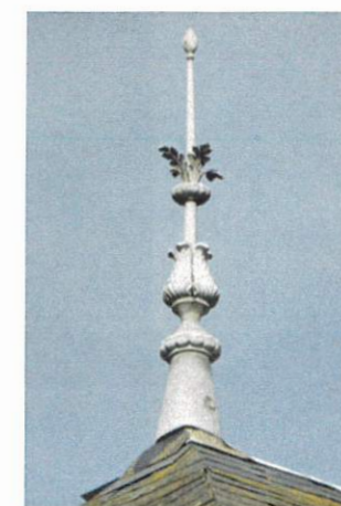
Epi de faîtage protégeant le poinçon de charpente saillant.
