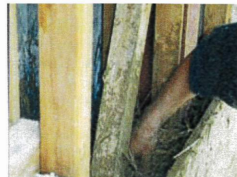
Banchage pour mélange terre/paille
