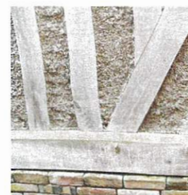
Réfection du remplissage en mélange chaux/chanvre. Un enduit à la chaux hydraulique naturelle viendra protéger le remplissage à l'extérieur
